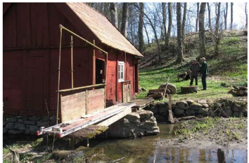
Möllan i Tibbaröd. Huset över 150 år gammalt. Nytt tak och den lilla bron över ån under reparation. Vattnet till kvarnen togs in mitt under huset, se dammluckan längst bort.
