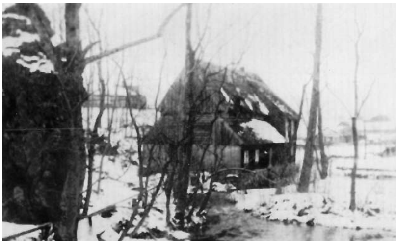
Själva garveriet låg nere vid ån. Fotot är taget vid 1900-talets början, uppe från kvarndämnet. Till vänster ses klippan i förkastningsbranten. Anläggningen var 16 m lång och 8 m bred. Ekbark till skinnberedningen levererades av traktens bönder.
