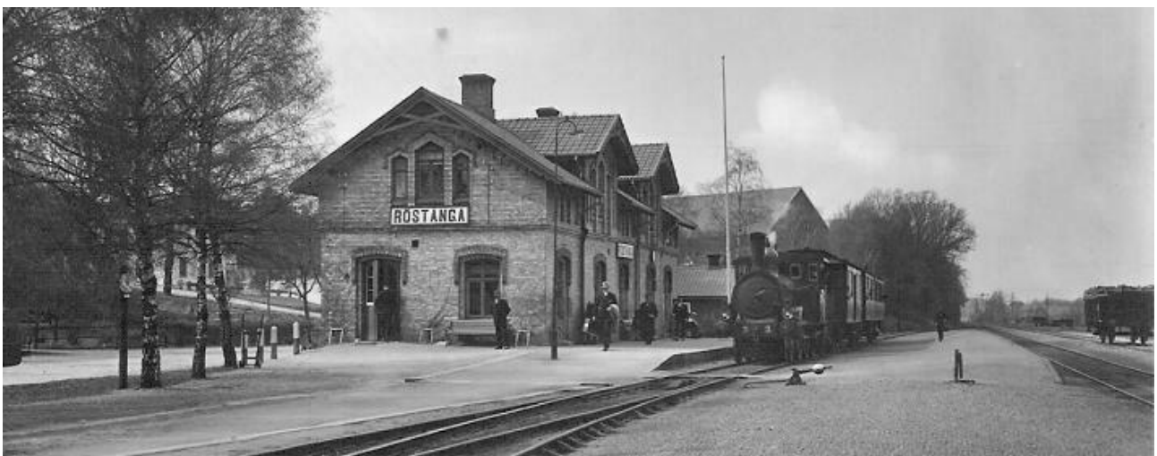
Järnvägsstationen då poststationen var på denna södra gavel.
